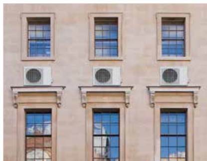
Fasad med vanliga utomhusaggregat.
